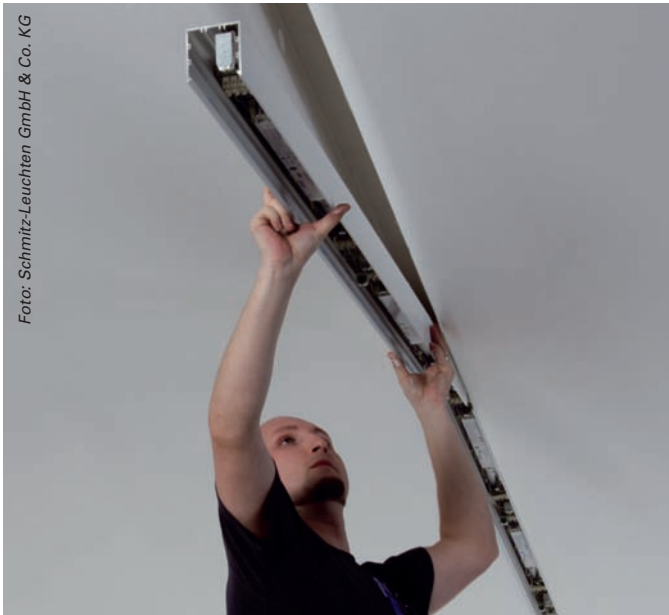
Exakt abgestimmt: Elektriker montieren die passgenaue Leuchteinheit ganz einfach in den Gipskanal.
