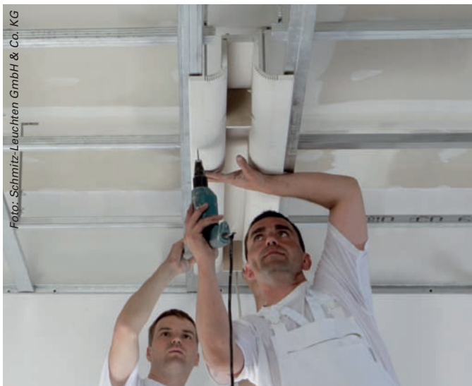
Einfach, schnell und sauber: Trockenbauer verschrauben den vorgefertigten Gipskanal mit der Unterkonstruktion der Gipskartondecke.
