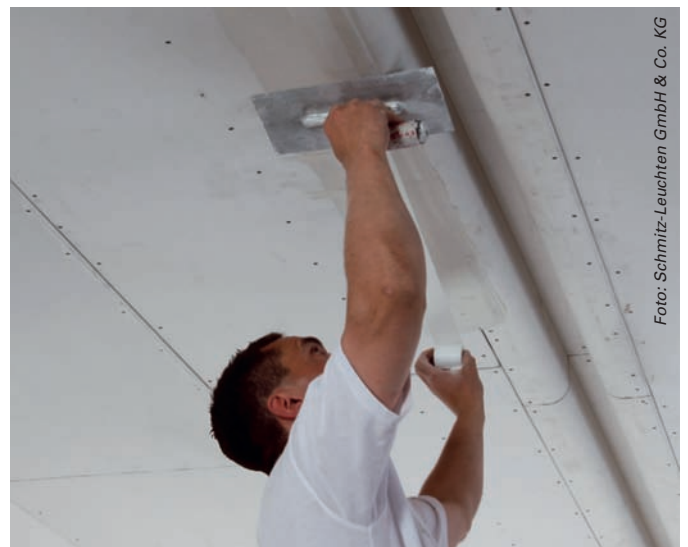
Die abgerundeten Kanalkonturen fügen sich randlos in die Gipskartondecke ein. Anschließend werden die Fugen verspachtelt und die Decke wird gestrichen.
